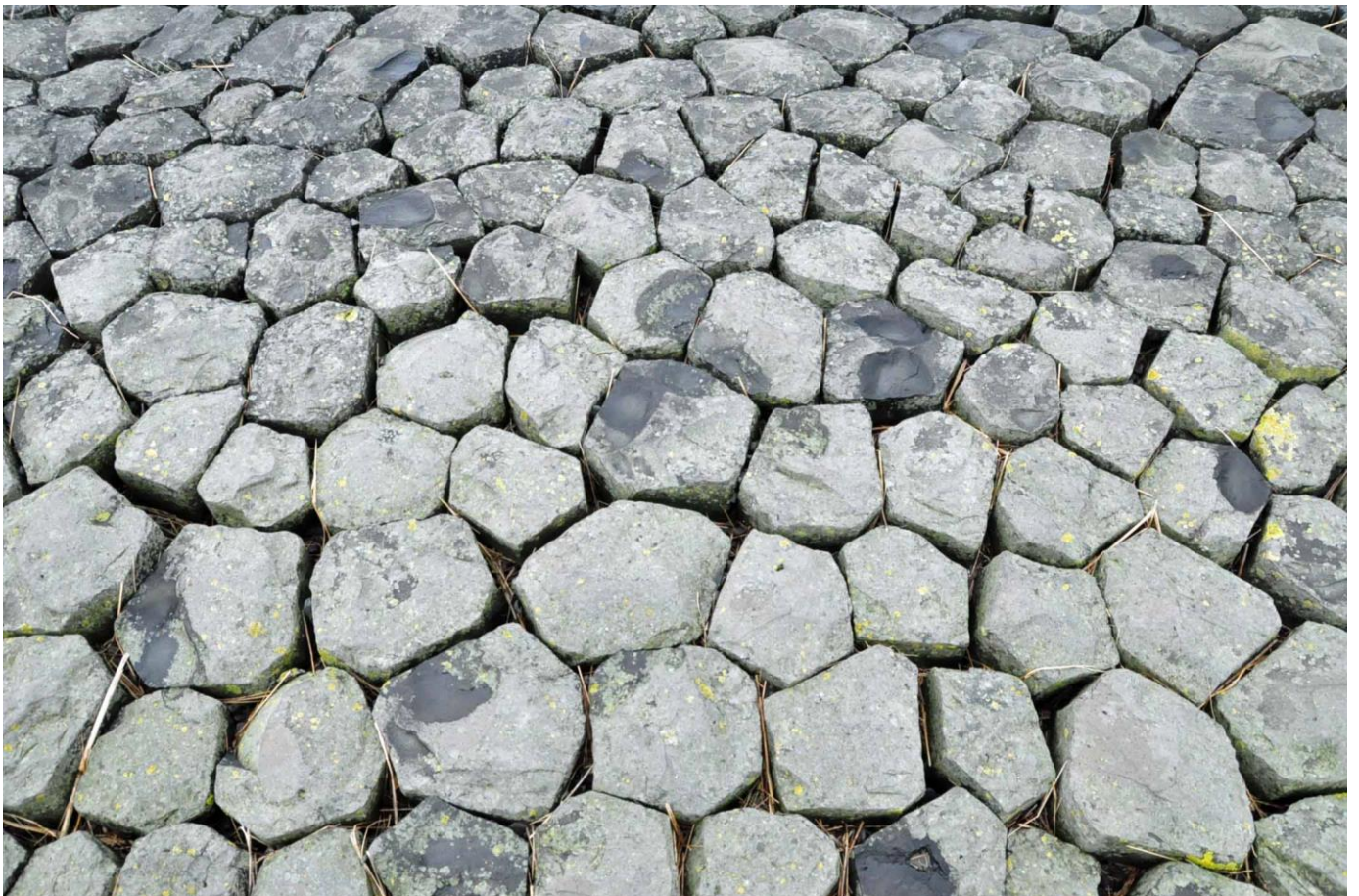
Westerwälder Säulenbasalt zur Uferbefestigung
